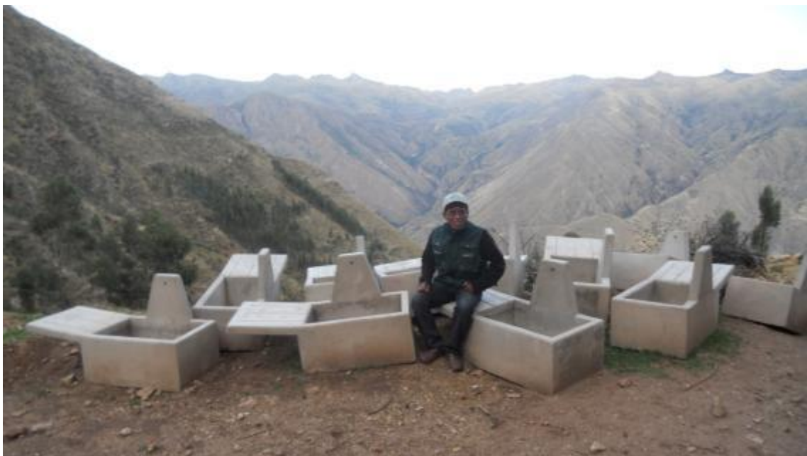
Bateas prefabricadas transportadas para su instalación
