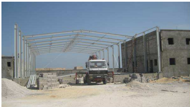
Figure 2 Evolution des travaux dans la chambre froide à Nouadhibou
